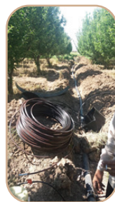
شکل ۲-۱۳: پیاده‌سازی سیستم آبیاری زیر سطحی در باغ سیب (استان آذربایجان شرقی)
