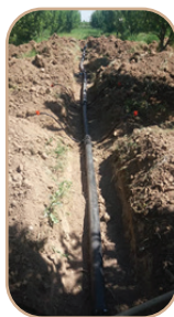
شکل ۲-۱۳: پیاده‌سازی سیستم آبیاری زیر سطحی در باغ سیب (استان آذربایجان شرقی)
