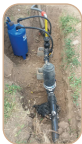
شکل ۲-۱۳: پیاده‌سازی سیستم آبیاری زیر سطحی در باغ سیب (استان آذربایجان شرقی)
